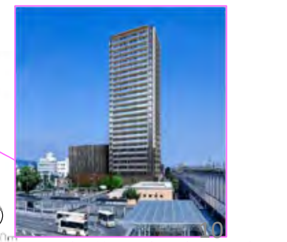
JR前橋駅北口地区第一種市街地再開発事業 (事業中：住宅、店舗、一時預かり保育事業)
